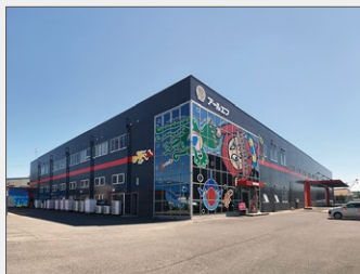
四国事業所 土地: 1,301坪 建物: 延べ932坪 6月稼働
