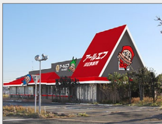
浜松事業所 土地: 641坪 建物: 延べ130坪
